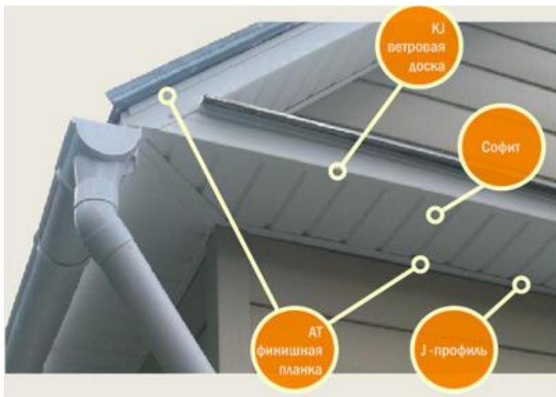
Используя уровень, сделайте на стене метки, параллельные нижнему краю фронтона, далее вдоль меток прикрепите планку J-профиль. Также прикрепите J-фаску к краю фронтона, завершив ее финишной планкой. Отмерьте расстояние между планками, Вычтите 6 мм для возможного расширения - сжатия. Отрежьте софит по этой длине и установите его в планки J-профиль и J-фаску. Закрепите каждую панель по центру перфорационного отверстия.
